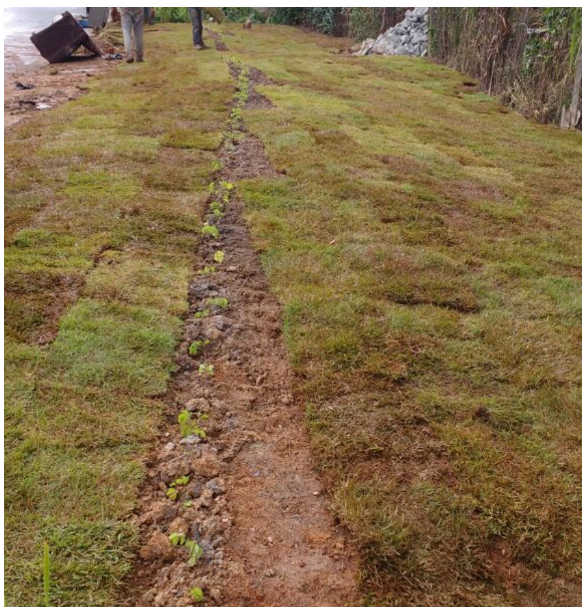
Figura 34 – Depois: capina, limpeza e plantio na área da Nascente do Alyrio
