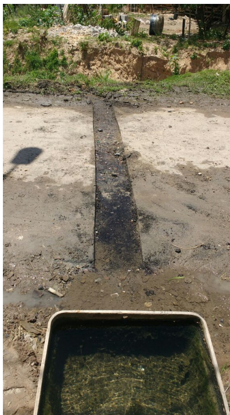
Figura 23 – Construção de via para escoamento da água na Nascente da Felicidade - Fonte: Gos Florestal
