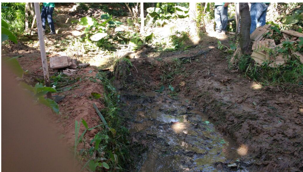
Figura 32 – Depois, capina e limpeza de poço na Nascente do Alyrio
