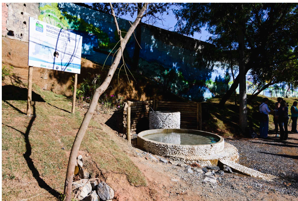
Figura 58 –Obra concluída com instalação da placa e detalhe da saída do desvio de escoamento da água da chuva vinda da Escola - Fonte: Gos Florestal
