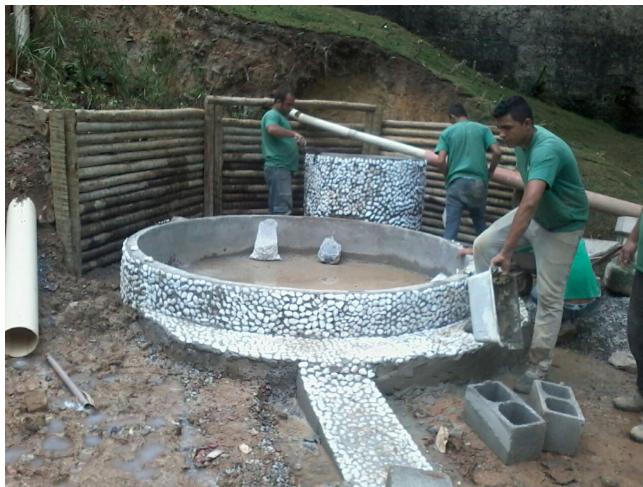
Figura 22 – Construção de reservatório de água e estrutura de contenção de barranco na Nascente da Felicidade- Fonte: Gos Florestal
