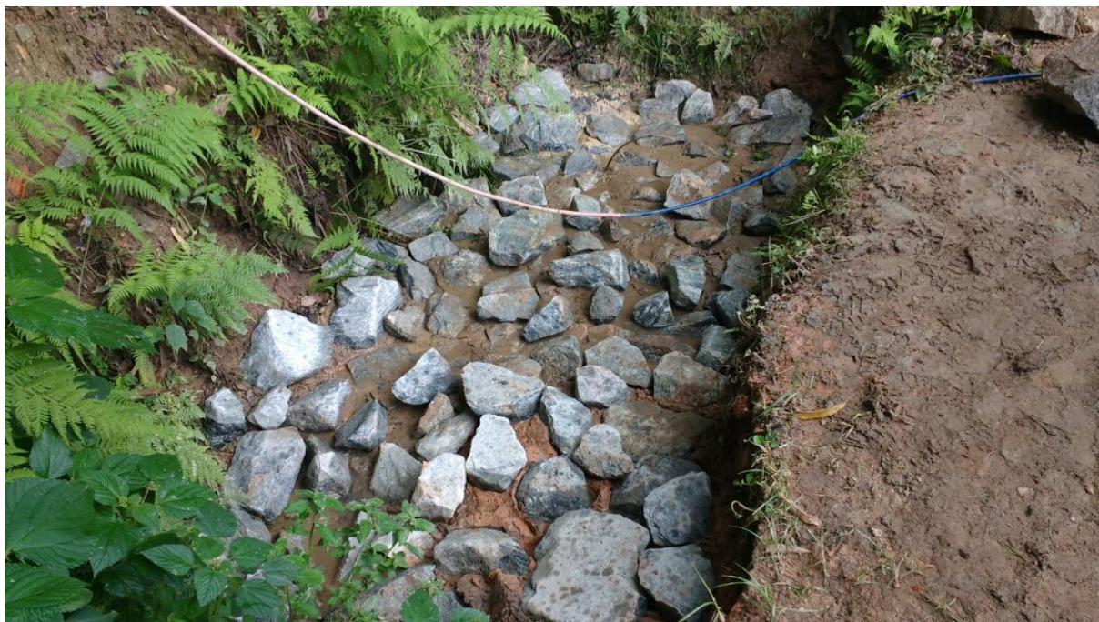
Figura 41 – Limpeza e melhoria de poço na Nascente do Alyrio.
