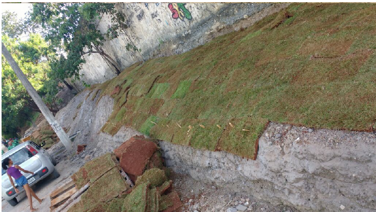
Figura 52 – Depois: capina, limpeza e plantio de grama na Nascente da Felicidade - Fonte: Gos Florestal
