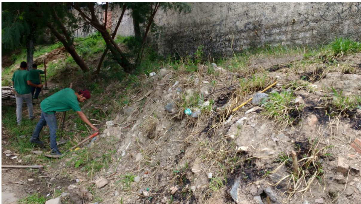
Figura 20 – Limpeza e retirada de entulho na Nascente da Felicidade
