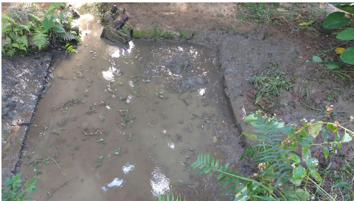
Figura 42 – Limpeza e melhorias em poço na Nascente do Alyrio
