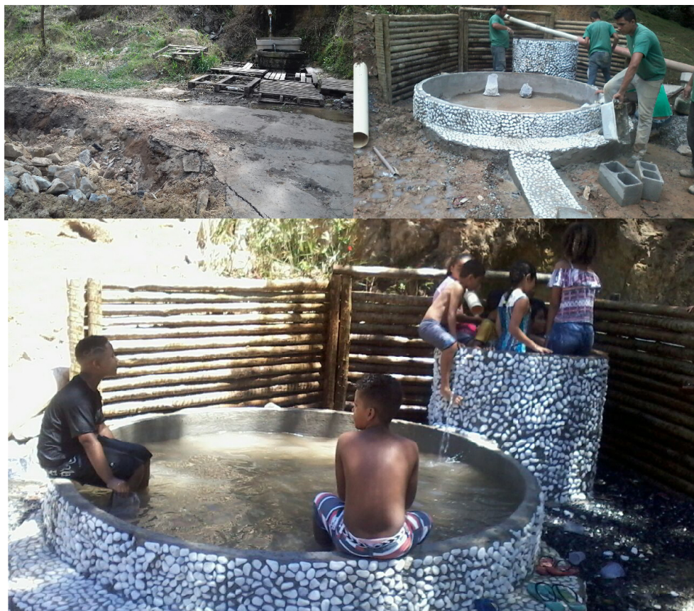
Figura 57 – Antes e depois limpeza, contenção de barranco e construção de reservatório na Nascente da Felicidade - Fonte: Gos Florestal
